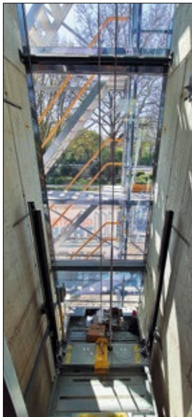
Der Fahrstuhlbau geht fleißig voran.
