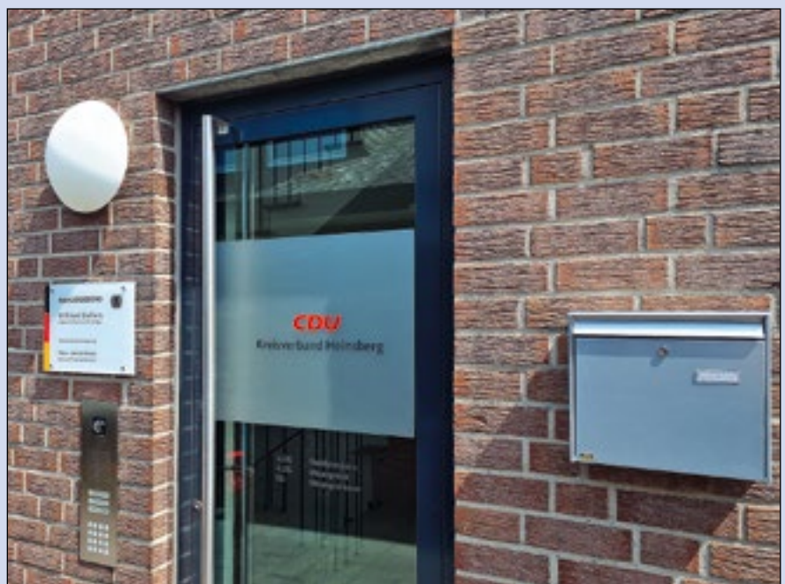
Für die Zeit der Umbauarbeiten wurde an der Kreisgeschäftsstelle ein Ersatzbriefkasten installiert.
